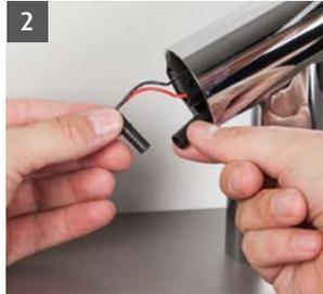
Magnetventil abstecken und gegen den Uhrzeigersinn heraus drehen.
