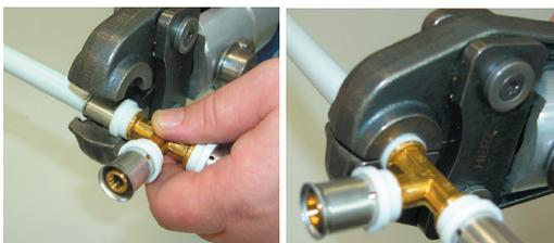
Mit Pressgerät oder Handpresszange Verpressung durchführen. Rohre müssen spannungsfrei sein. Der Pressvorgang ist beendet wenn der vollständige Backenschluss erreicht ist.
