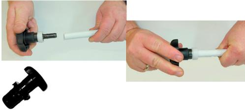
Das Rohr wird mit dem zum Durchmesser passenden Werkzeug entgratet und kalibriert. Die anfallenden Späne sind aus dem Rohrende zu entfernen. Wird der Kalibrierer in eine Bohrmaschine eingespannt, darf die max. Drehzahl von 10 U/min nicht überschritten werden. Zwei vollständige Umdrehungen reichen für die Kalibrierung und Entgratung der Rohrende aus.
