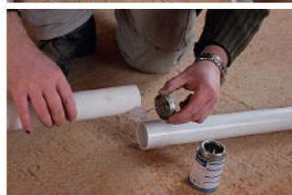
Führen Sie nun die Schlauch-Einzugsleitung nach unten zur Unterputzbox zurück. Dazu verwenden Sie zwei weite 90° Depot-Bögen. Diese werden in den Deckendurchbruch gesteckt und mit der Schlauch-Einzugsleitung verklebt.
