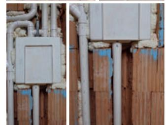
Die Schlauch-Einzugsleitung kann nun beidseitig mit PU-Schaum ausgeschäumt werden.
