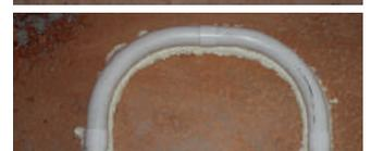
Als nächstes muss die Saugleitung verlegt werden. Diese kann je nach Einbauvariante nach oben oder nach unten führen.
