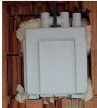
Anschließend wird der Teleskoprohr-Köcher für das Teleskoprohr mit der Unterputzbox fixiert. Dazu wird der Teleskoprohr-Köcher unter der Unterputzbox angesetzt und die Hülse vom Inneren der Unterputzbox eingeklebt.
