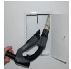
Ist der Handgriff verräumt, muss der Schieber wieder in seine Ausgangsposition nach oben geschoben werden und der Zentralstaubsauger schaltet sich aus.
