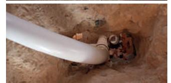
Danach wird die Länge der verbleibenden Rohrstücke zwischen Unterputzbox und der ersten beiden Depot-Bögen ermittelt und zugeschnitten. Anschließend werden diese verklebt.
