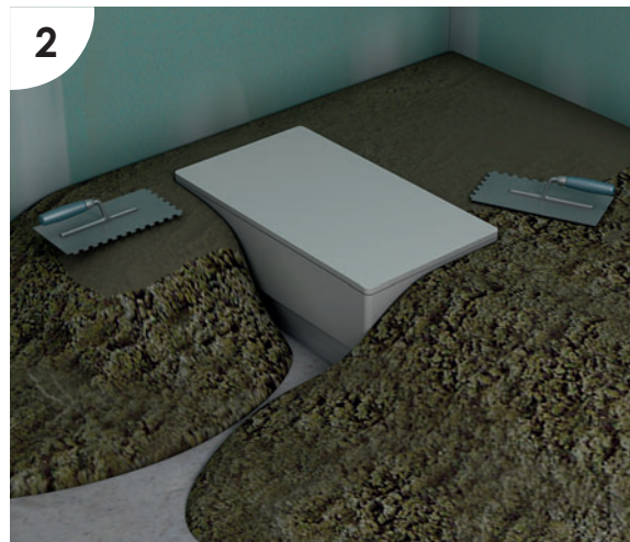
EINBRINGEN DES ESTRICHS
