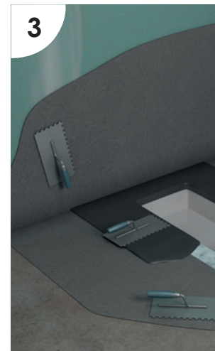
EINBINDEN DER ABDICHTUNG
