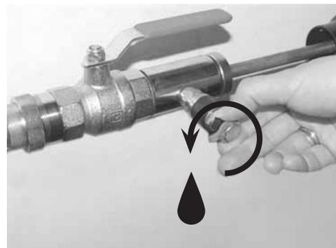
16. Entleerungsventil schließen und Kugelhahn (5) öffnen.
