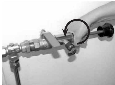
13. Thermostatoberteil aus der Nuß ziehen, reinigen bzw. austauschen.
