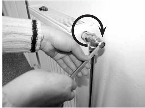
22. Thermostatkopf, Handantrieb oder Schraubkappe montieren.
