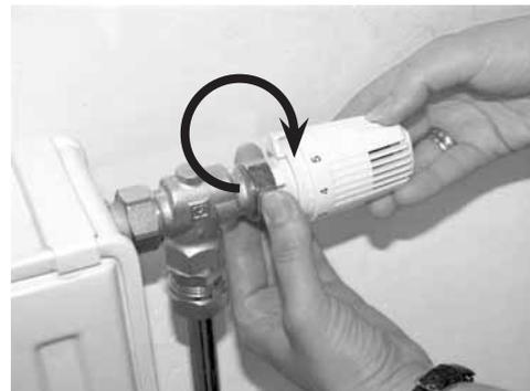
2. Oberteil mit Schlüssel SW 18 gegen den Uhrzeigersinn lockern.
