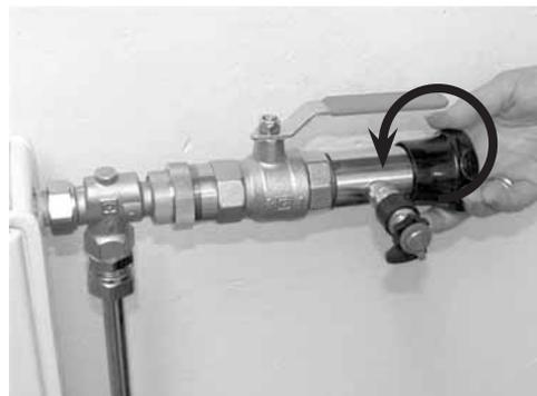
9. Betätigungsspindel langsam vom Ventil bis zum Anschlag wegziehen. Die Gummidichtung hält den Oberteil in den Steckschlüssenaufsatz und fördert es dabei in die Schleuse.
