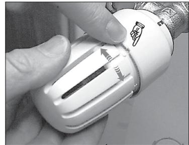
Jetzt die Verriegelungshülse ohne Werkzeug Richtung Handrad verschieben, bis die Handradskala verdeckt wird und die Hülse hörbar einrastet.
