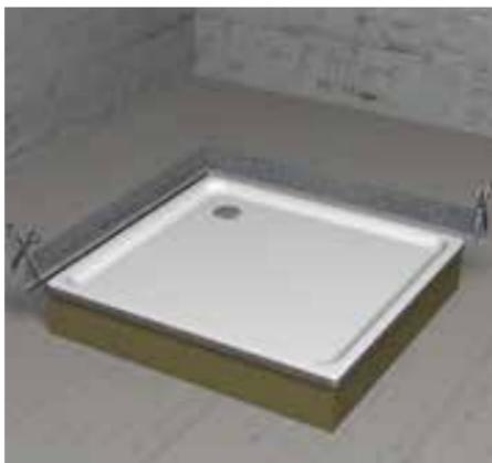
Das Wannendichtband mit Zugabe von 2 cm zuschneiden
