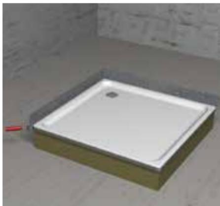
Das Dichtband im Bereich des Butyls mit einem Anpressroller andrücken.
