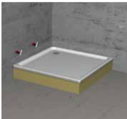
Nun in über das aufgeklappte Wannendichtband mit der Flüssigabdichtfolie streichen.
