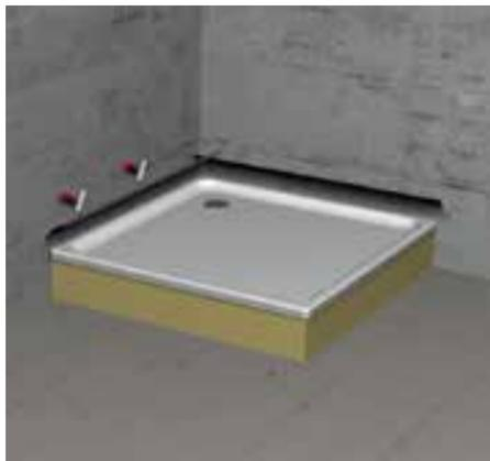
Mit Flüssigabdichtung hinter dem Dichtband abdichten und das Wannendichtband in die Flüssigabdichtung drücken.
