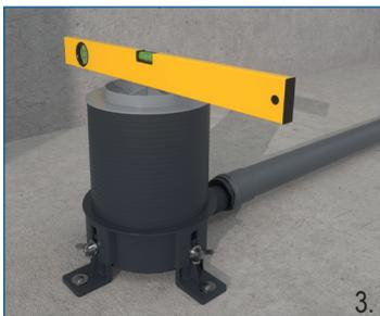
DE Ablaufkörper mit Abflaufleitung verbinden, Rohrgefälle über die Befestigungswinkel in der Höhe einstellen, Ablaufkörper gemäß Abb. 3 waagrecht ausrichten.
