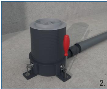
DE Löcher bohren und den Ablaufkörper mittels Befestigungswinkeln und Schrauben an die Rohdecke fixieren.
